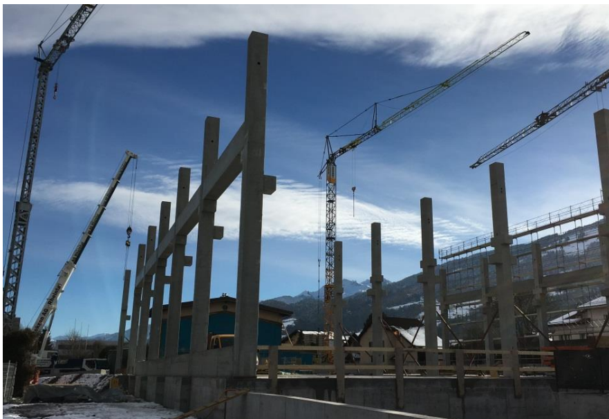
Bau Produktionshalle Januar 2018
